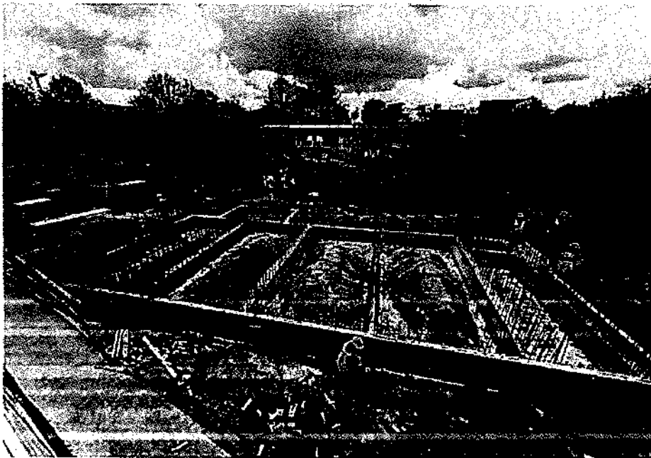
Figura 1.5. Executie structura de rezistenta statie de butelii oxigen
